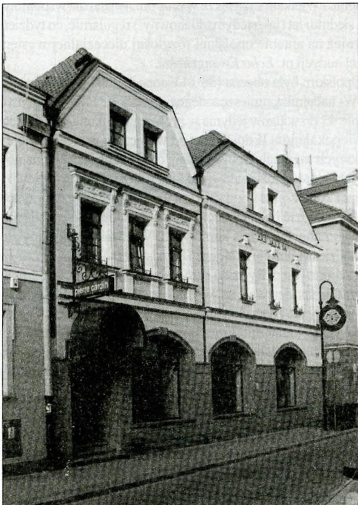
Budynek radia diecezji opolskiej przy ul. B. Koraszewskiego 7-9 w Opolu
