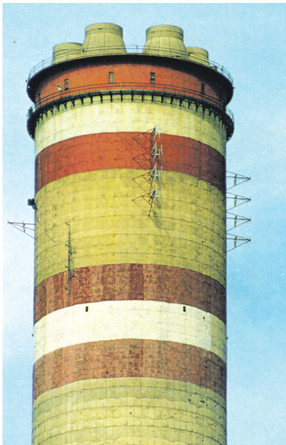
Widok anten rozgłośni diecezjalnej na kominie Elektrowni „Opole” w Brzeziu, w lecie 1997 r.
