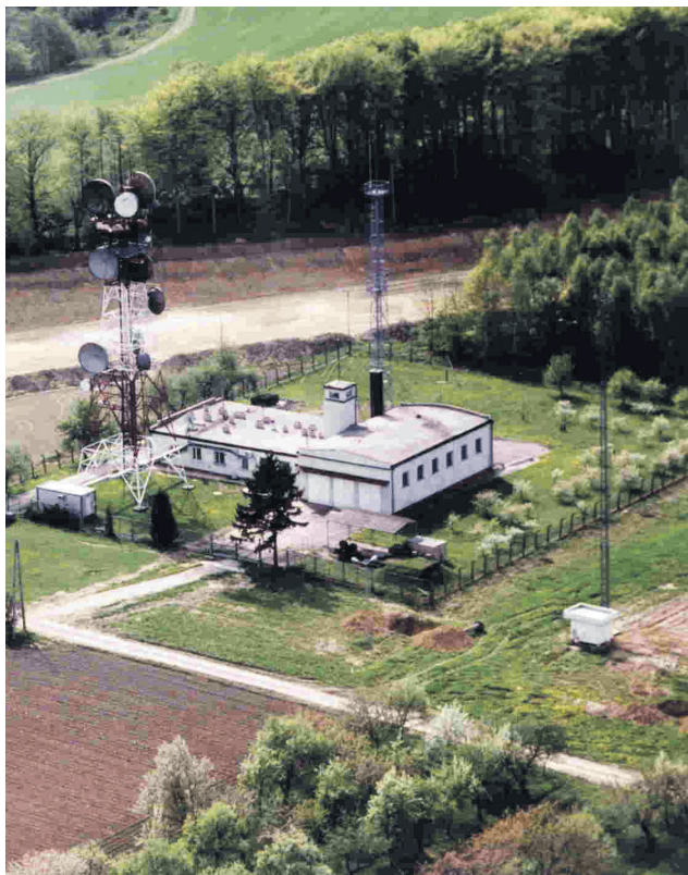
Własna stacja nadawcza radia diecezjalnego w Wysokiej k. Góry św. Anny, obok budowanej autostrady A-4 (maszt i kontener w dolnym prawym rogu zdjęcia), w lecie 1997 r.
