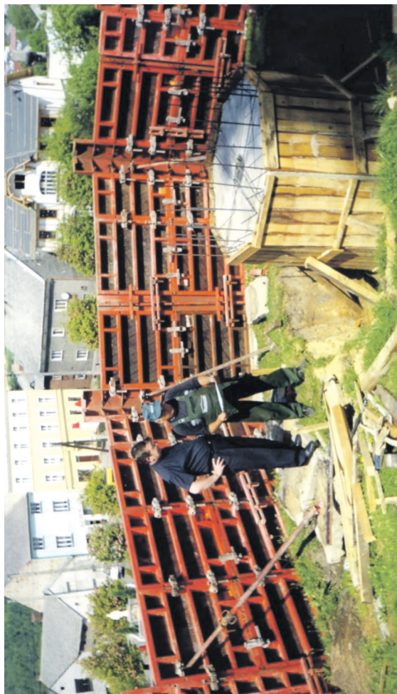
Początki budowy fundamentów pomnika papieża Jana Pawła II na Górze św. Anny, kwiecień-maj 2000 r.
