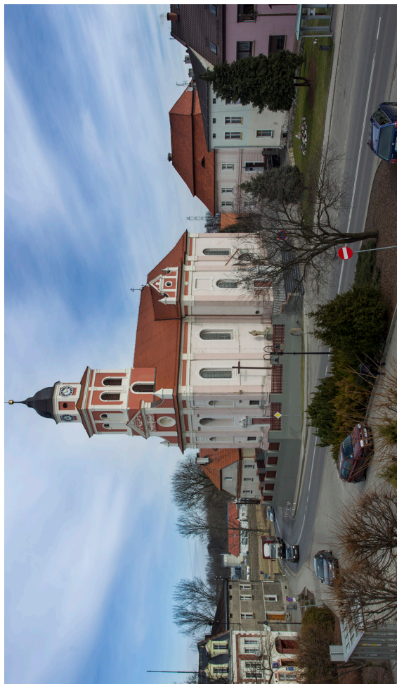
Kościół parafialny w Prószkowie - po dwóch wielkich remontach: dachu - w 2009 r. i muru oporowego oraz placu kościelnego w 2014 r.
