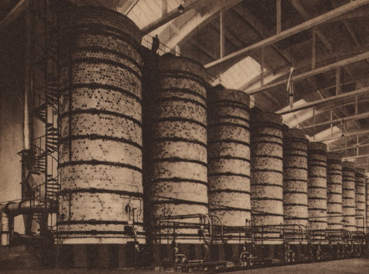
Mościce — a) wieże absorbcyjne w instal. kwasu azot. b) fragment zabudowań fabrycznych
