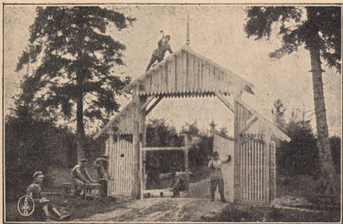
Budowa bramy wjazdowej
