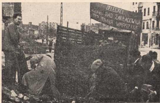
Delegaci włoskich rad zakładowych pra- cują przy odbudowie Warszawy.
