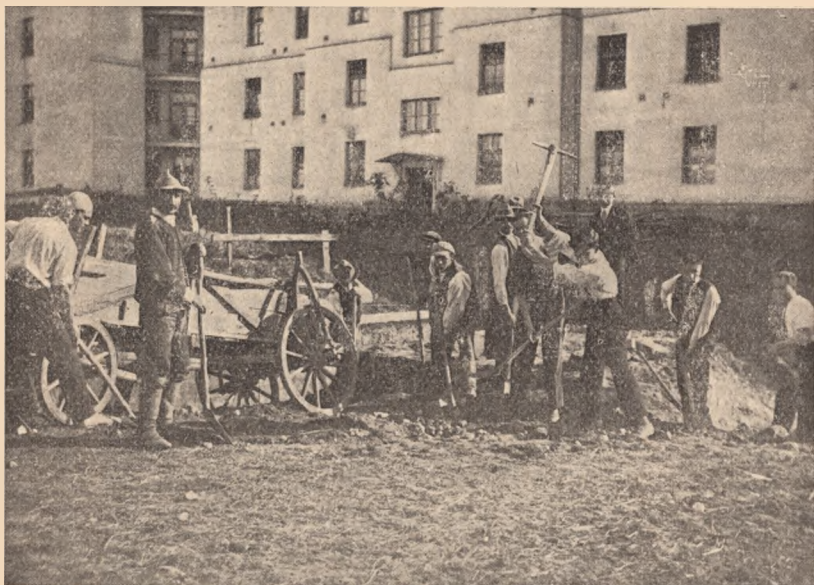
Drużyna akademicka przy budowie Domu Akademickiego im. Prezydenta Ignacego Mościckiego.
