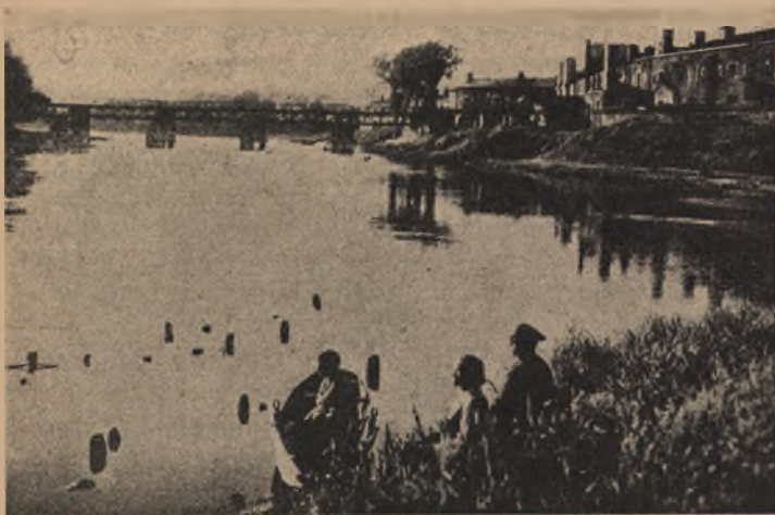
Brześć nad Bugiem. Widok na jeden z mostów
