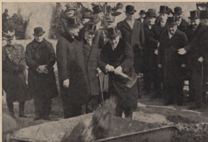
Rozpoczęcie robót przy budowie kolei Warszawa—Radom w dniu 19.III. b. r. P. premier Prystor rzuca pierwszą łopatę ziemi
